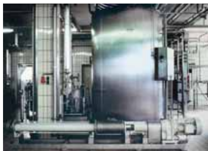
Насос seepex NS 35-24, продукт: фруктовый сок, давление: 24 бар, температура: 65°C, производительность: 6-13,5 м 3 /ч
