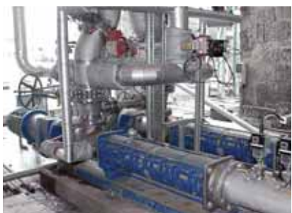
Насос seepex BN 130-12, продукт: выжимка в винокурении, 10% TR, вязкость: 2000 сП, температура: 65°C, давление: 8-12 бар, производительность: 40 м³/ч
