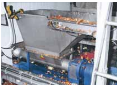
Насос seerex BTM 17-12, установлен в конце контрольного транспортера для размельчения и транспортировки отходов лука, производительность: 8 м 3 /ч
